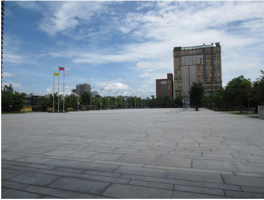
朝北(面臺灣大道)
