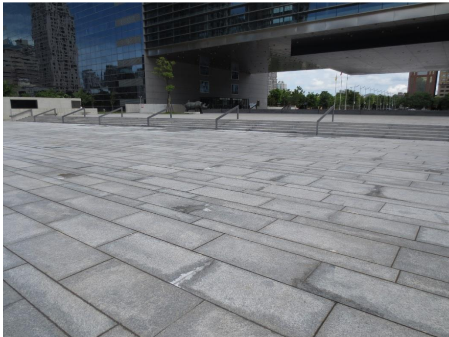
朝北(面 1 樓中央區挑高川堂)
